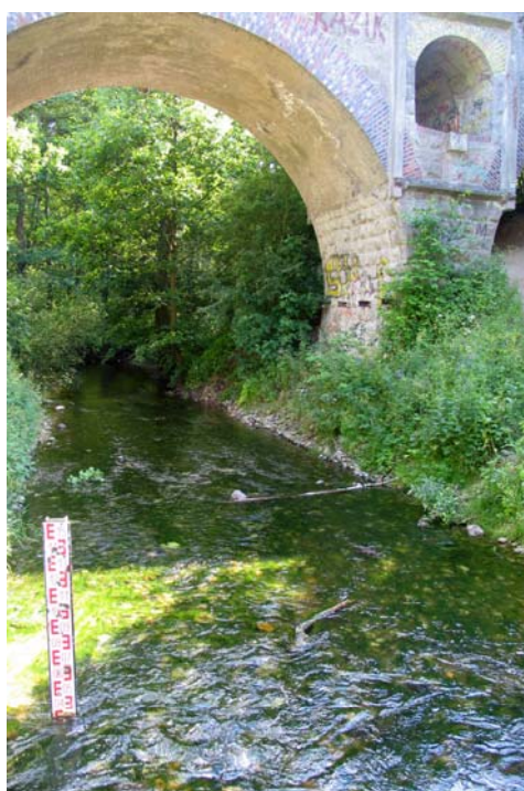
Fot. 6.4. Nieużytkowany wodowskaz na Orli poniżej Jeziora Więcborskiego
