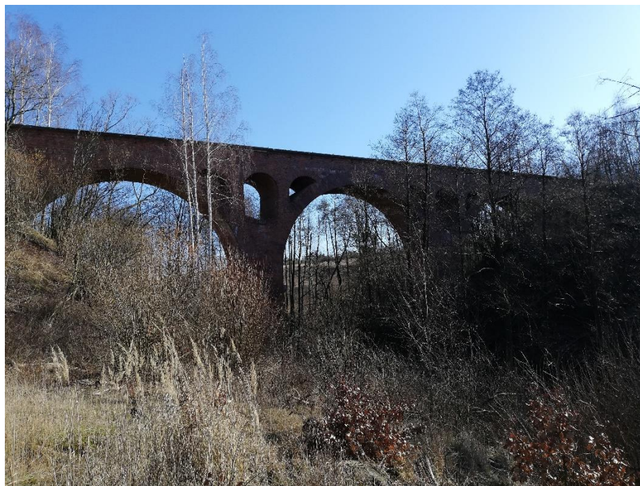
Fot. 2. Most kolejowy nad Sępolenką w Obodowie (fot. Krzysztof Wojtkowiak)
